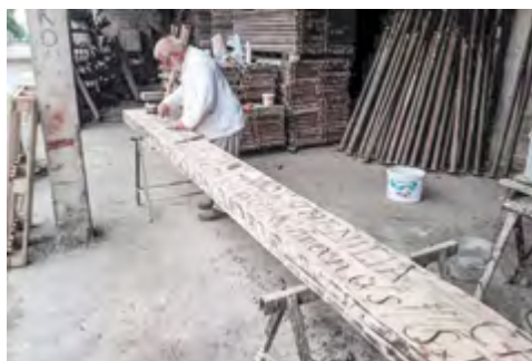
Slika 13. Obnova drvene grede (foto: M. Ožanić, 2018.)
